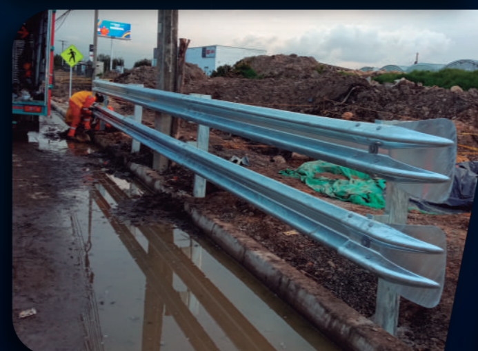
SUMINISTRO E INSTALACIÓN DE DEFENSA METALICA CL 80 Km 1 VÍA COTA CTO DE OBRA No. 04 DE 2022 PROVELESCO S.A.S
