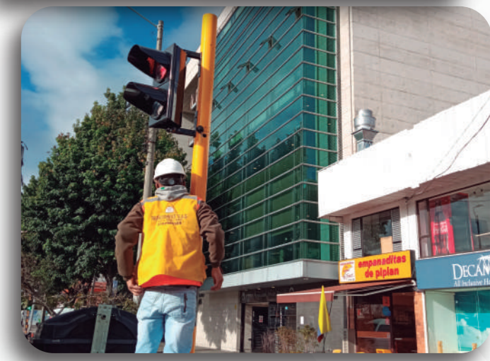
AFOROS CON CAMARAS KR 9 ENTRE CL 140 Y 147 CTO FDLM-LP-03-2021 196 DE 2021 PAVIOBRAS S.A.S
