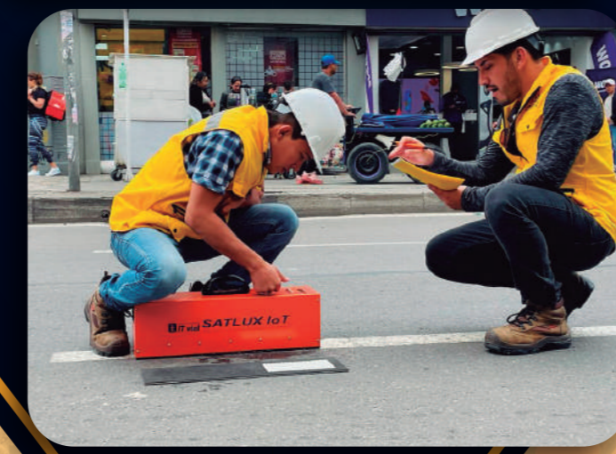
TOMA DE REFLECTIVIDAD AV KR 13 BARRIO UNIDOS CTO IDU 1695 Y 1696 CONSTRUCTORA FG
