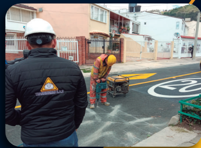
INSTALACIÓN DE ESTOPEROS METALICOS LOCALIDAD USAQUEN - BOGOTA CTO No. 145 DE 2019 JP DISEÑOS E INGENIERIA SAS
